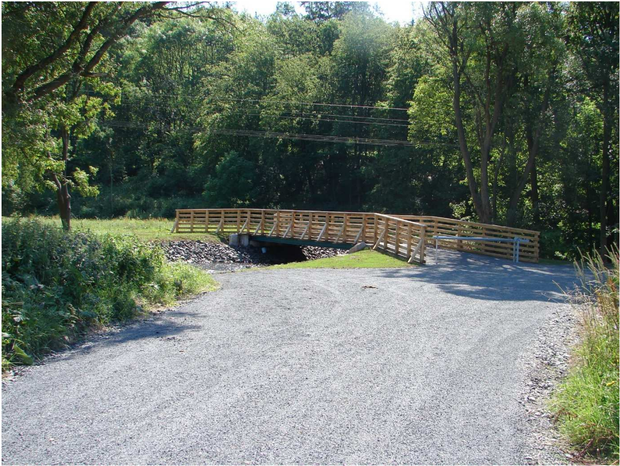
Abbildung 151: KG3 (Neidhartshausen 2007) über das Projekt errichtete Brücke
